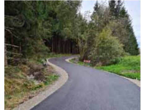
Geländer zur Sicherheit im Kurvenbereich im Nachtrag
