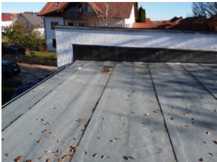
Dach und Mauerwerk der Aussegnungshalle sind repariert
