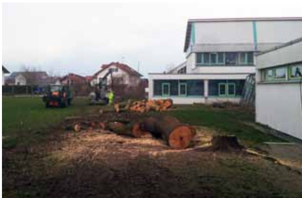
Die Vorarbeiten für den Erweiterungsbau laufen auf Hochtouren / Foto G. Först
