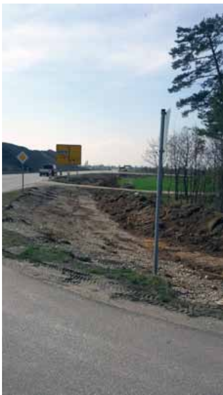
Die Bauarbeiten an der LL22 gehen zügig voran / Foto S. Morgenländer
