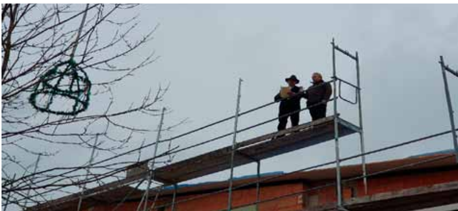
Links die Richtkrone sowie Zimmermann Alois Inning und Bürgermeister Günter Först hoch oben auf dem Gerüst – beim Verlesen des Richtspruches
