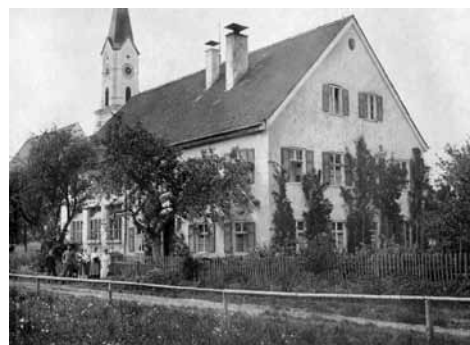
Das Unteriglinger Schulhaus im Jahr 1935, erbaut 1866/1908, abgebrochen 1972
