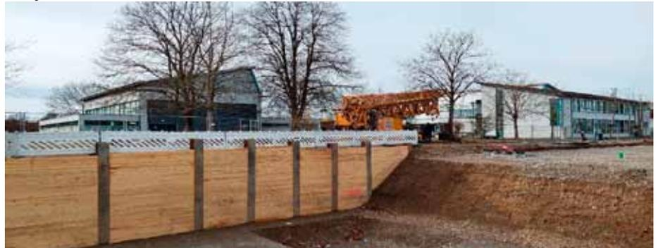
Für die Absicherung der in der Müller-Hahl Straße verlegten Versorgungsleitungen musste eine sogenannte Berliner Verbauung (stabile Holzwand) errichtet werden.
