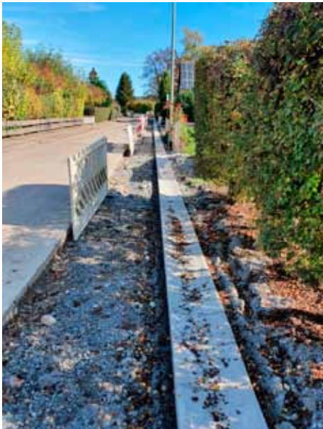
Neue Straßenentwässerungsrinne im Kapellenweg / Foto: Claudia Jett-Schwarz
