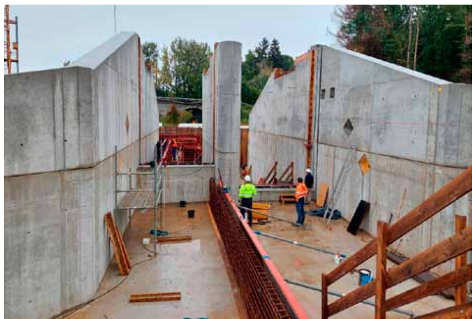
So sieht es an der Baustelle derzeit aus - ist ganz schön heftig
