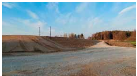
Der Damm des Regenrückhaltebeckens entlang der Bahnlinie, nahezu höhengleich
