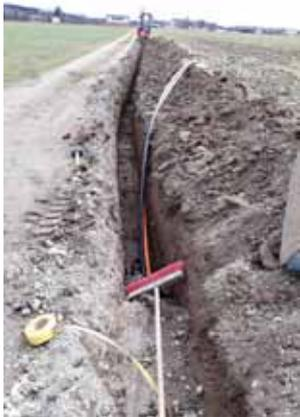
Hier wird die vorhandene 20KV Überlandleitung abgebaut und in den Boden verlegt. Auch in den nächsten Monaten
