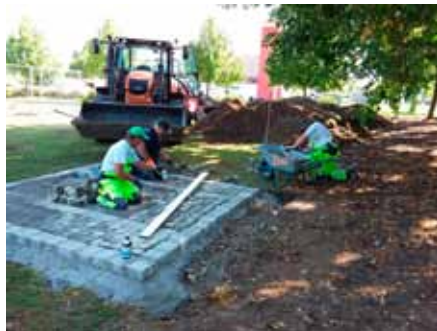
Franz Wachter, Josef Gayer, Uli Wachter beim Bau des Sitzplatzes
