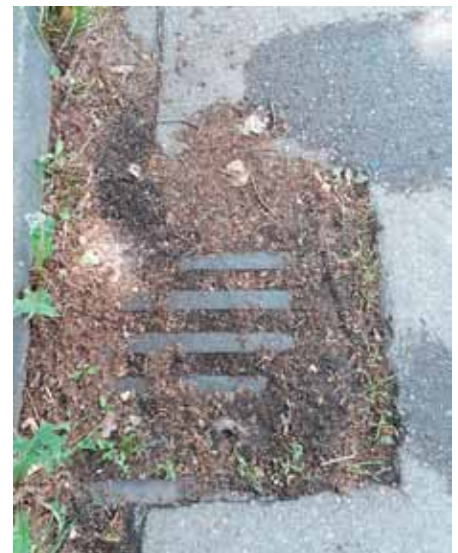
Verstopfte Sinkkästen lassen bei Regen kein Wasser durch.
