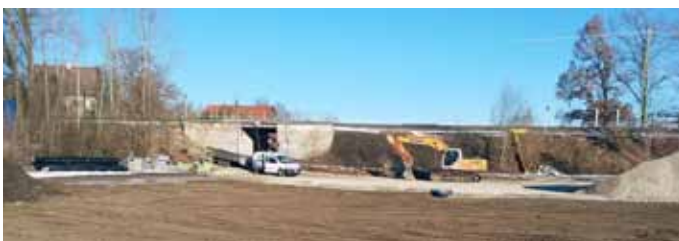
Die Baustelle südlich der Bahnlinie
