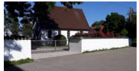
Die renovierte Friedhofsmauer
