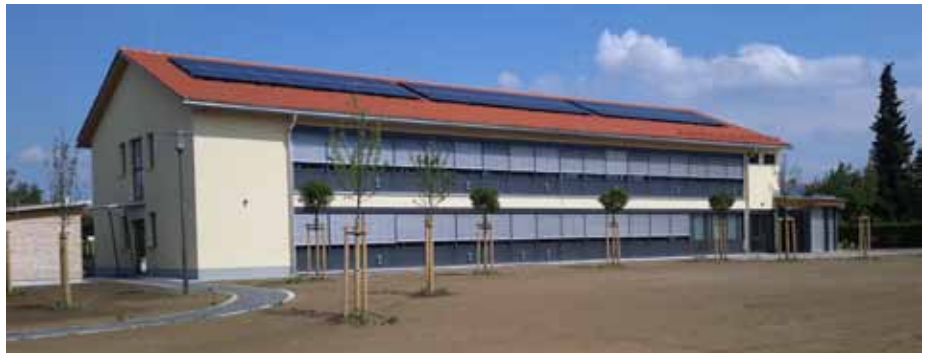
Das neue VG Gebäude von Westen aus gesehen
