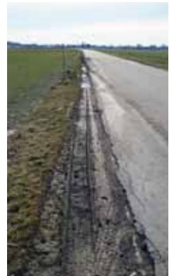
Die Ortsverbindungsstraße Holzhausen - Großkitzighofen
