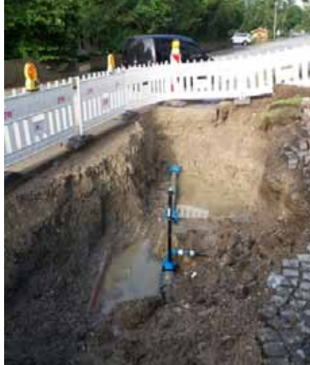
Nachdem das Leck gefunden wurde, musste die geplatzte Leitung ausgetauscht werden
