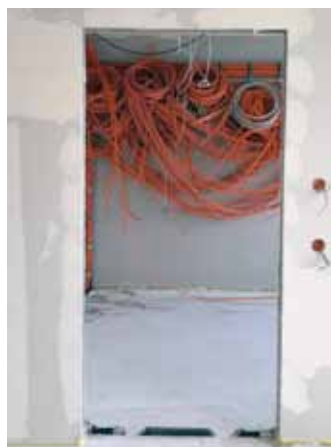
Auch hier werden die Elektriker noch Ordnung reinbringen
