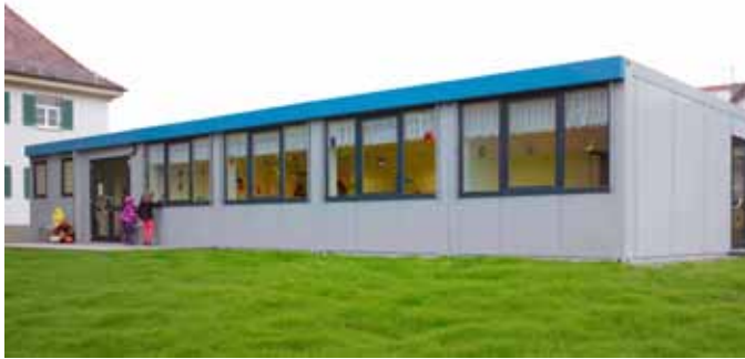
Beispiel für eine Containerlösung an der KITA Weil
