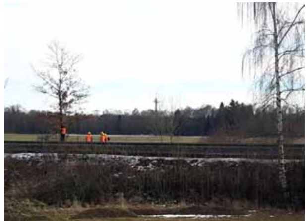
Rückschnitt-Arbeiten an der Bahnlinie München - Lindau / Foto: Günter Först
