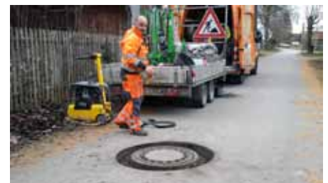
Die neuen Kanalschächte werden gesetzt
