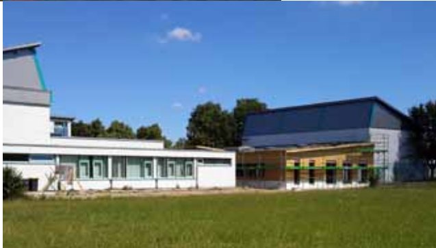
Die Bauarbeiten am Gebäude für die neue Mittagsbetreuung gehen gut voran Fotos: Günter Först
