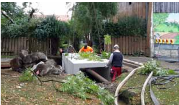
Die neue Brücke wird an der Schulstraße eingesetzt
