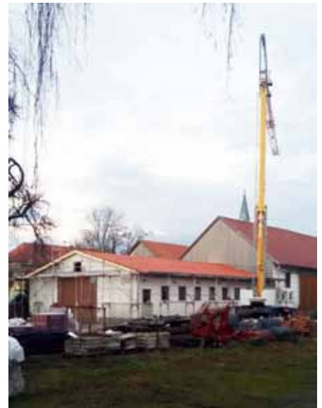
Das Dach des Iglinger Bauhofes musste ausgetauscht werden. Die Arbeiten sind schon abgeschlossen
