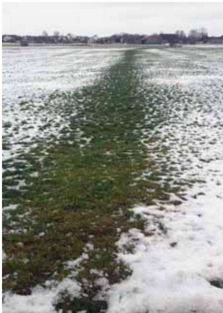
Den Verlauf der Nahwärmeversorgung sieht man im Winter deutlich auf der Iglinger Flur
