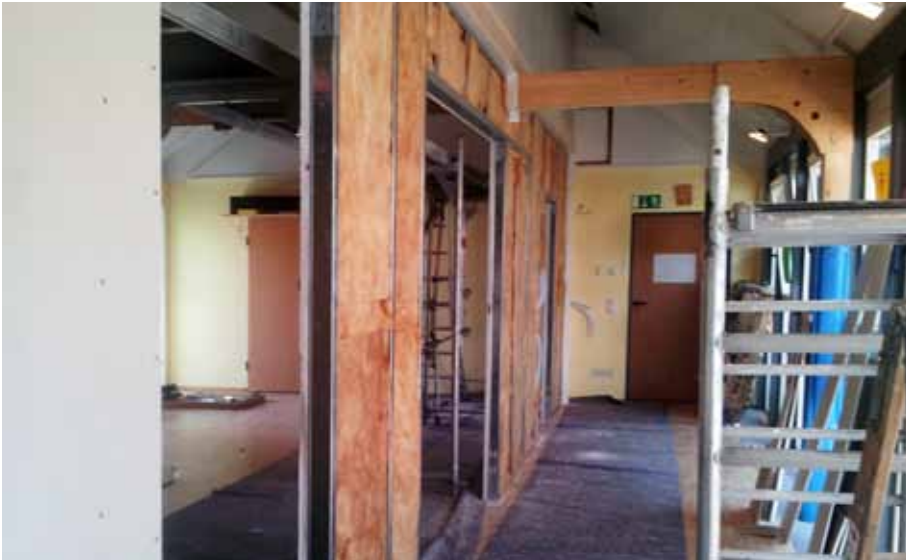
Die Zwischenwand im Turnraum ist eingebaut
