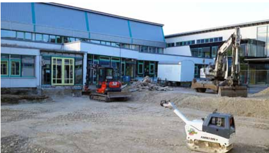
Die Bauarbeiten für den Anbau Mittagsbetreuung schreiten gut voran
