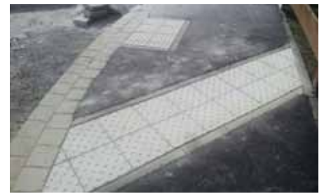
Behindertengerechte Übergänge des neuen Gehweges
