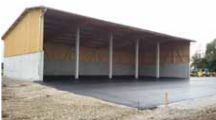
Die nun fertige Hackschnitzelhalle in Unterigling / Foto: S. Morgenländer
