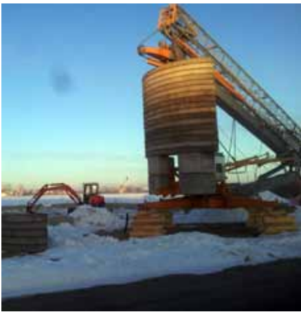
Kran im Gewerbegebiet Fotos Günter Först
