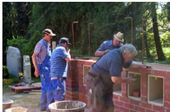
Die fleißigen Helfer beim Errichten der Urnenwand
