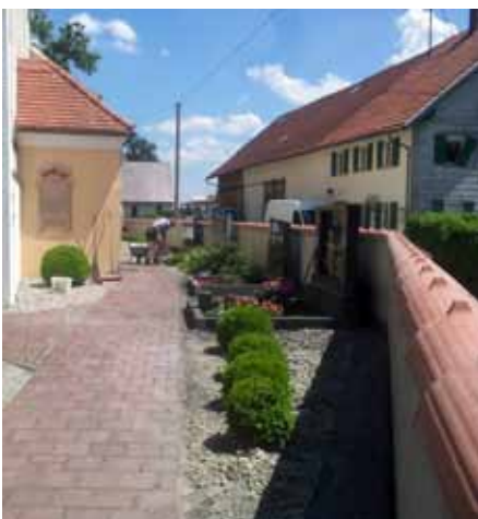
Die Unteriglinger Friedhofsmauer erstrahlt nach der Renovierung im neuen Glanz
