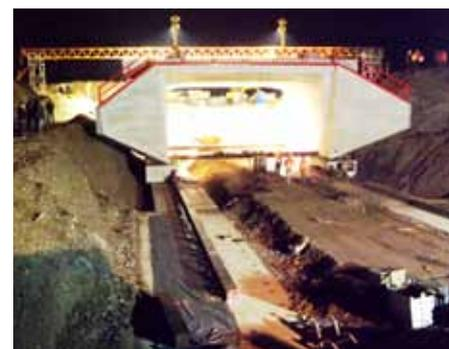
**Die neue Bahnbrücke wird eingeschoben, gut sichtbar die Fundamente links u. rechts. / Foto: Simpert Morgenländer**
