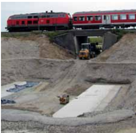
Die Bauarbeiten an der Bahnunterführung Welfenkaserne - Frauenwald gehen voran Foto: G Schurr
