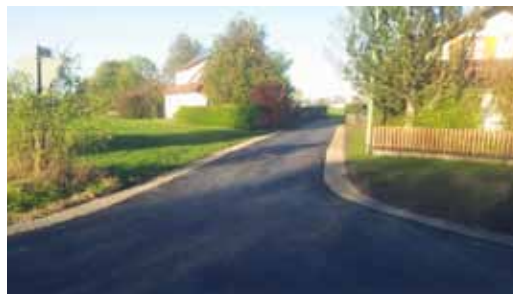
Der Bergteilweg nach der Sanierung
