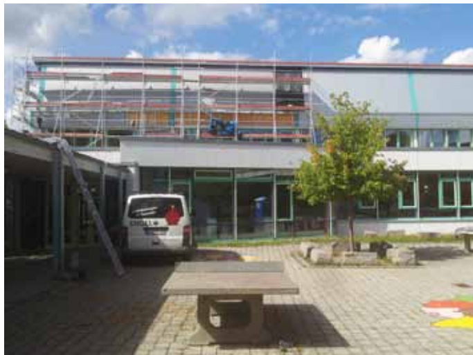
Die neue Verblechung wird angebracht / Foto: G. Först
