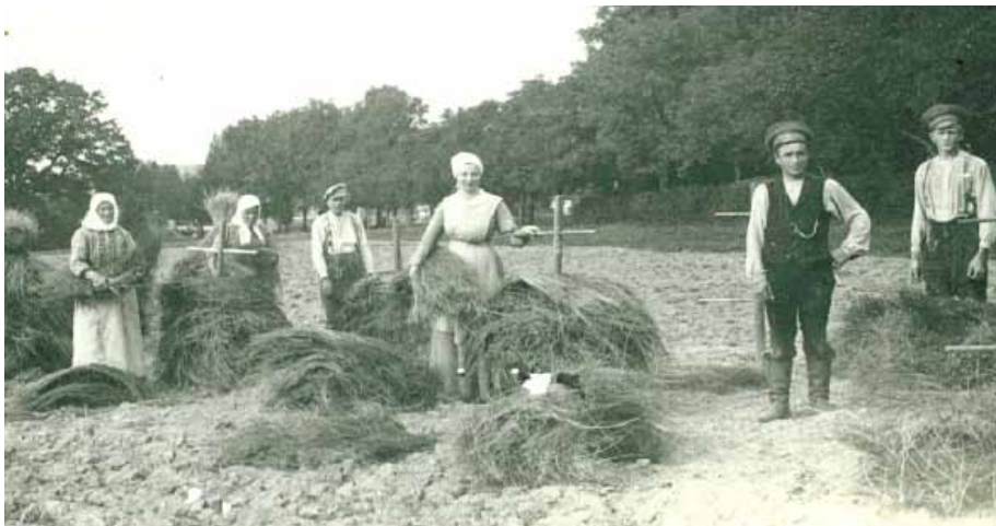
Arbeiten auf der Schloßwiese, rechts zwei gefangene Russen.
