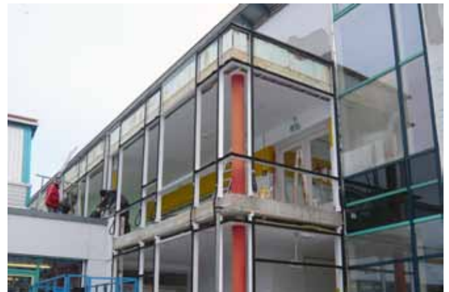
Die neue Fassadenkonstruktion wird eingebaut
