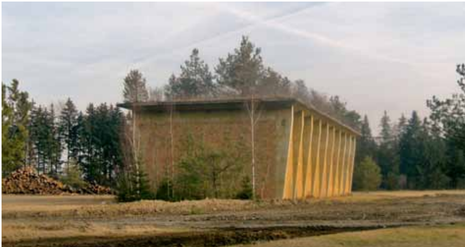
Eine der drei Lagerhallen, in denen Atomwaffen gelagert wurden.
