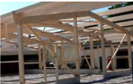
Im Jahr 2003 eröffnete Regens Wagner Holzhausen die Buchloer Zweigstelle der Magnus-Werkstätten in der Egon-Dittmann-Straße. Die neue Lagerhalle während der Bauphase, September 2012. / Foto: Ulrich Hauser
