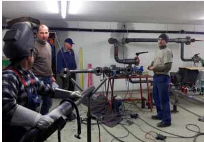
Die Übergabestation in der Grundschule wird installiert
