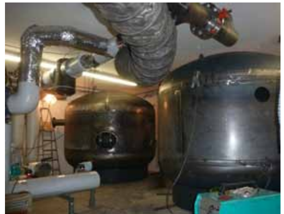
Die Boiler für die Nahwärme wurden jetzt installiert / Foto: Günter Först
