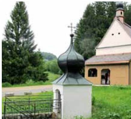
Bründl-Kapelle und Quellfassung der Heilquelle.
