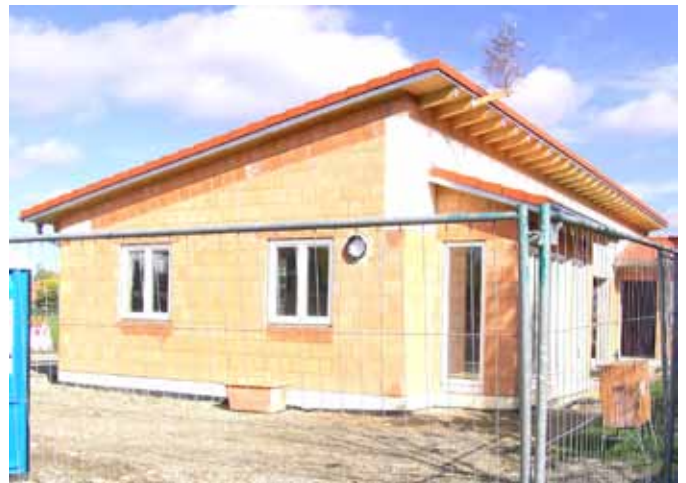
Die neue Kinderkrippe im Entstehen
