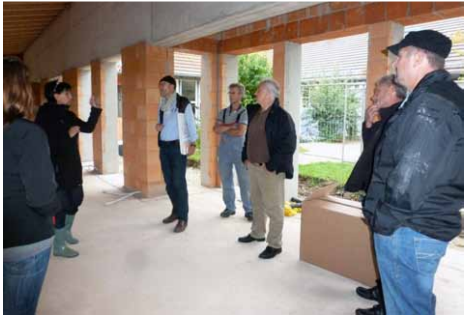
Jour fixe im Rohbau der Kinderkrippe / Foto: Günter Först
