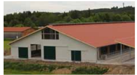
Der neue Milchviehstall im Mai 2012. / Foto: Firma Hörmann
