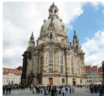
Die in 12 Jahren wieder aufgebaute Frauenkirche.
