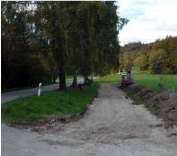
Der neue Radweg ist am entstehen Foto: Bgm. C. Weinmüller
