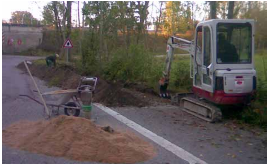
Aushub der Kabelschächte / Foto: C. Stede
