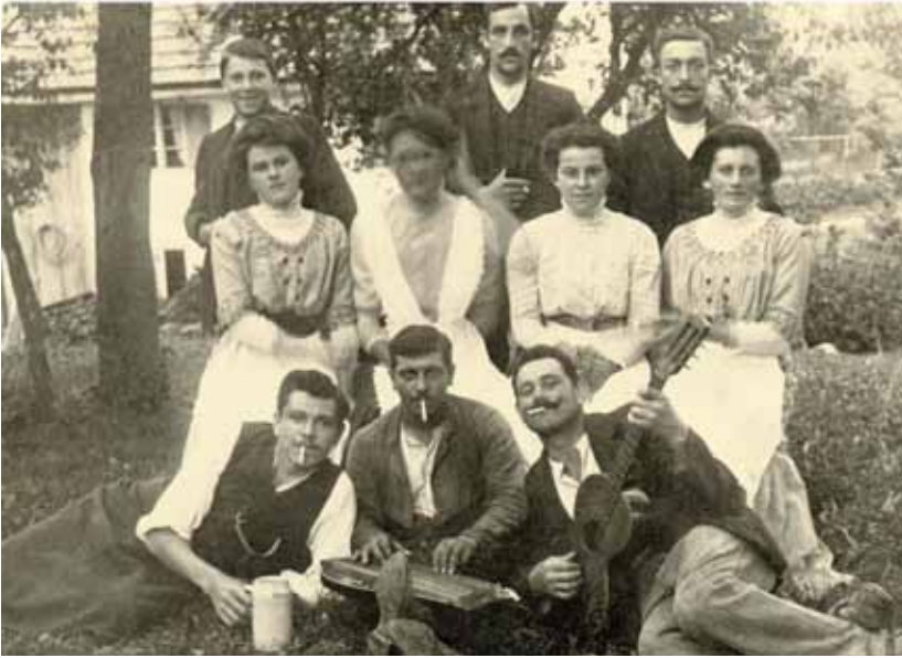
Italienische Wanderarbeiter wurden für den Bau der neuen Wasserleitung eingesetzt. / Fotos: privat/Archiv
