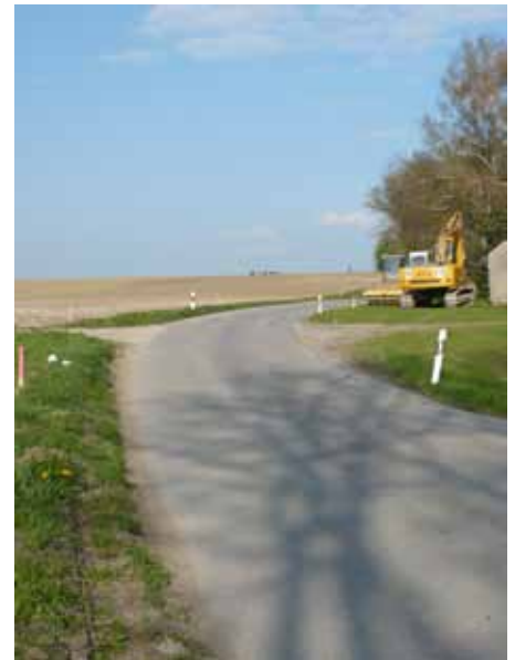
Baubeginn an der Ortsverbindungsstraße Igling Holzhausen
