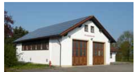
Die montierte Photovoltaikanlage auf dem Dach der FFW Holzhausen
