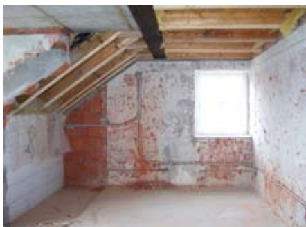
Die Florian'stube während der Renovierung.
