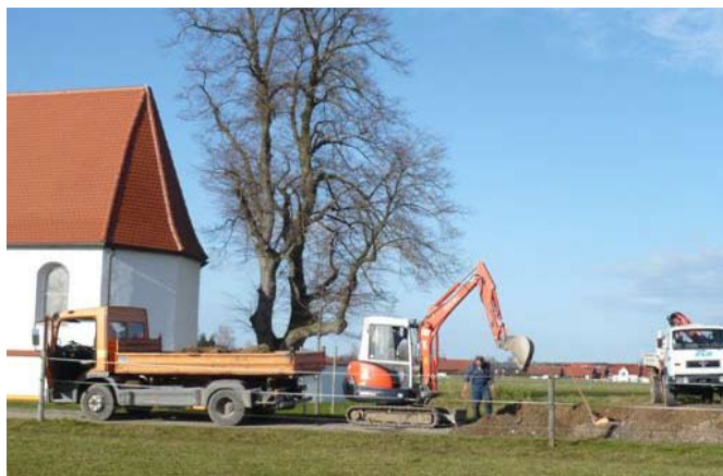
Verlegearbeiten an der Heimsuchungskapelle / Foto privat
