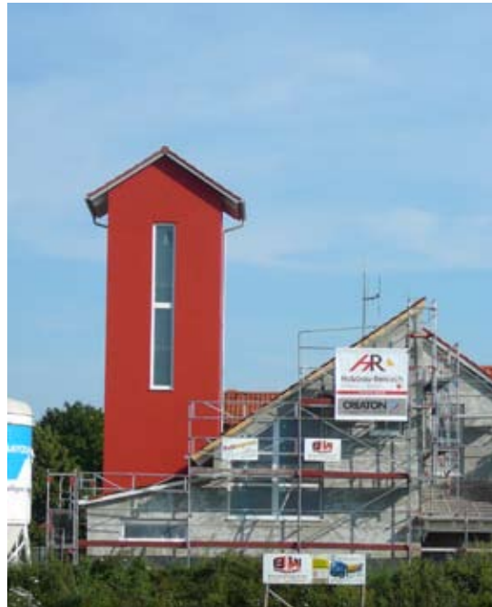
Der neue Schlauchturm, des im Umbau befindlichen Feuerwehrhauses Igling
