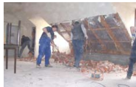
Abbruchmaßnahmen im Saal des Feuerwehrhauses im ersten Stock Foto: Andrea Rid
