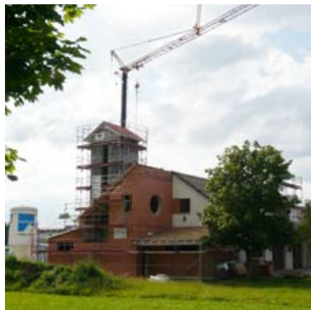
Umbau des Feuerwehrhauses Foto: C. Weinmüller
