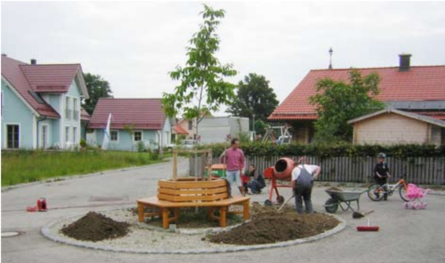
Christian Brückner und Peter Loßkarn beim Anlegen des Grünstreifens
