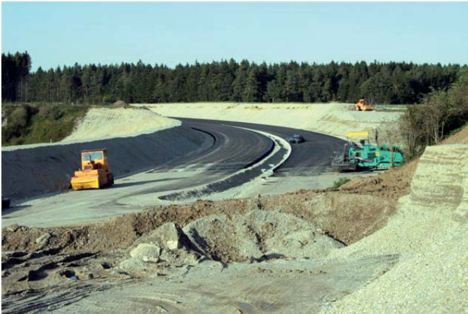
B17 neu: Bereich Riebelkiesgrube zwischen Igling u. Kaufering
