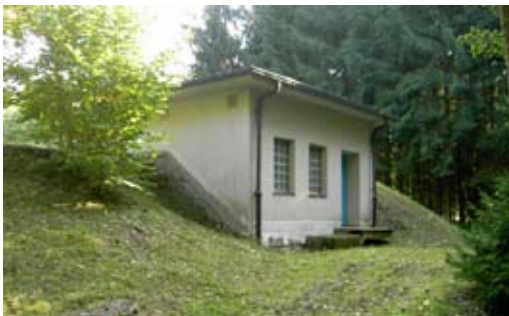
Hochbehälter bei Holzhausen / Bild: H. Szubert
