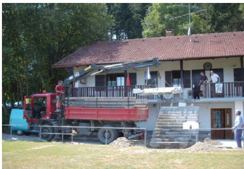
Mittel-Treppe des Sportheims bei deren Abriss Bild: Günter Först
