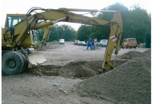
Die Arbeiten zur Errichtung des Kreisverkehrs an der LL 2 durch die Firma Riebel sind im vollen Gange.
