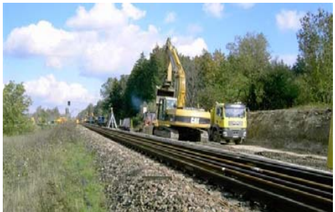
Bahngleiserneuerung zwischen Igling und Kaufering in vollem Gang / Bild: H. Szubert
