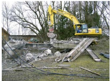
Abbruch Singoldbrücke Holzhausen Foto:SZ
